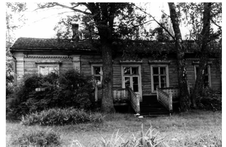
Rosavilla tässä vielä alkuperäisellä paikallaan Leppävaarassa kuvattuna terassin puolelta. Poikkeuksellisen suuret ikkunat ja lautavuoraus viittavat siihen, että talo oli alunperin tarkoitettu juhlaikäyttöön. KUVA ESPOON KAUPUNGINMUSEUMISEO
